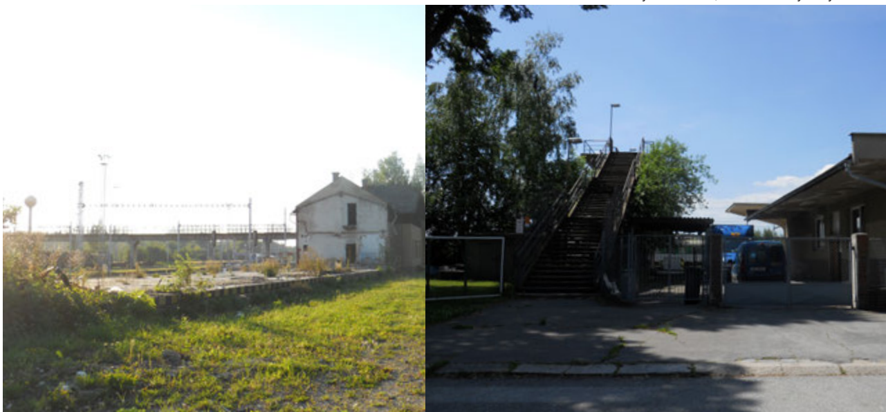
současný stav mostu, schodiště a výhledy z mostu
