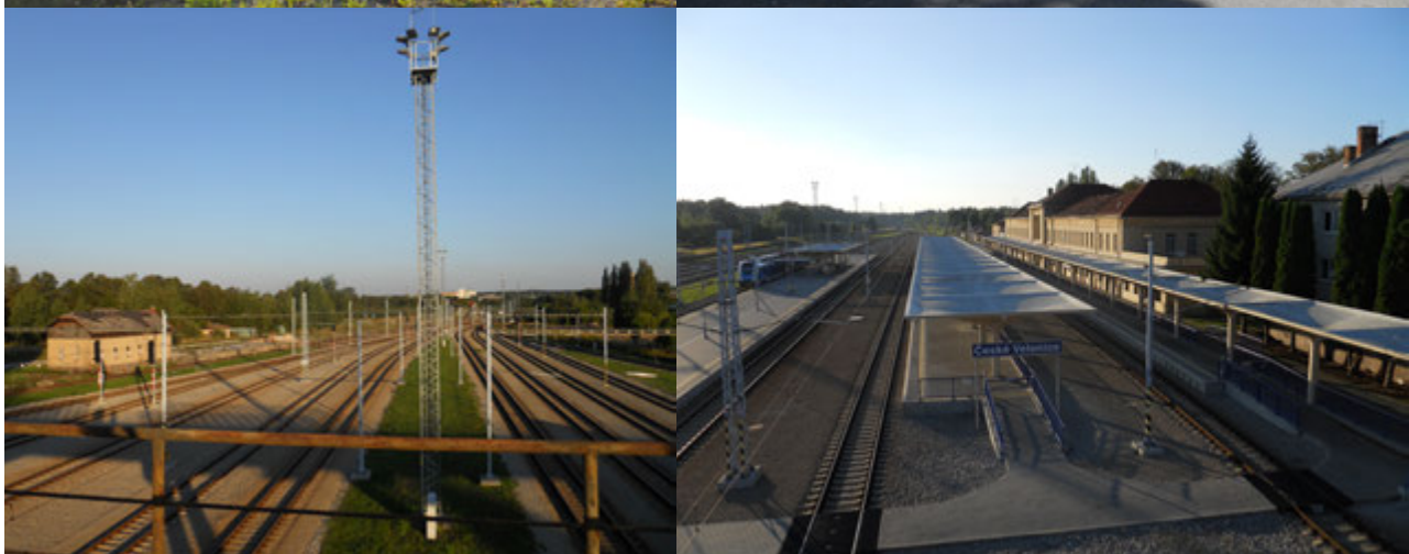
Úprava lávky u nádraží
